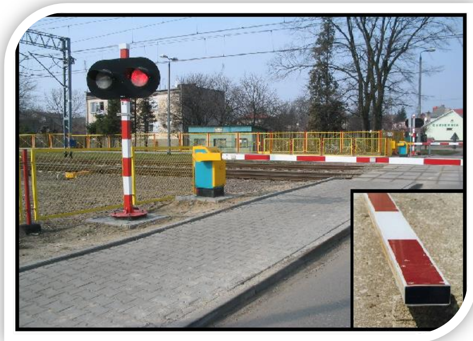
Aluminiowy drąg prostokątny samoczynnej sygnalizacji przejazdowej
