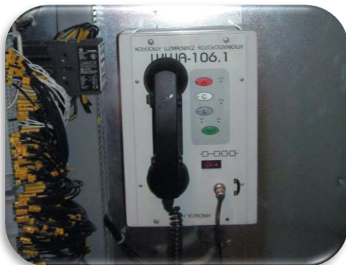
Słuchawka radiofoniczna i głośnik
