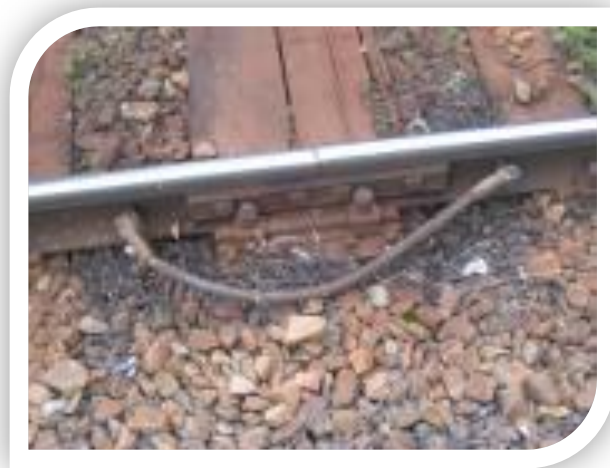
Łącznik szynowy krótki miedziany i podłużny stalowo –aluminiowy
