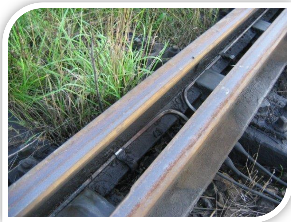
Druty oporowe podgrzewania rozjazdów (grzałki rozjazdowe)
