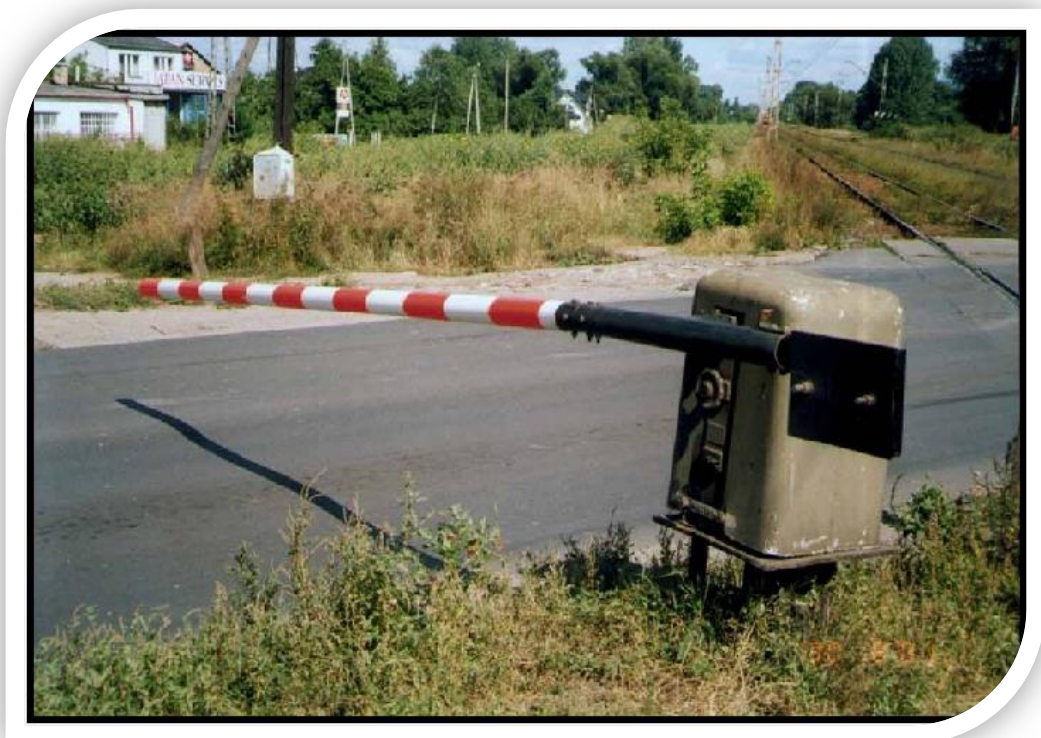
Aluminiowy półdrąg okrągły samoczynnej sygnalizacji przejazdowej
